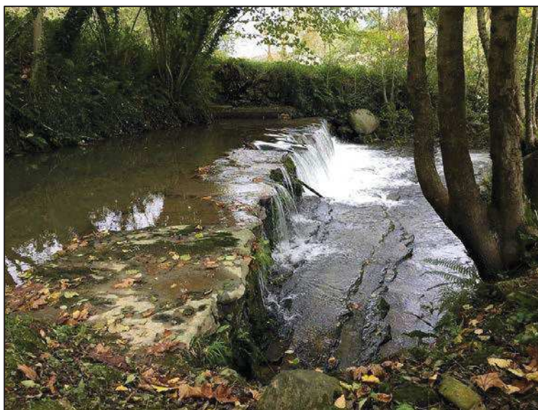
Foto nº8: Azud objeto del proyecto de demolición, de 0,9 m de altura
