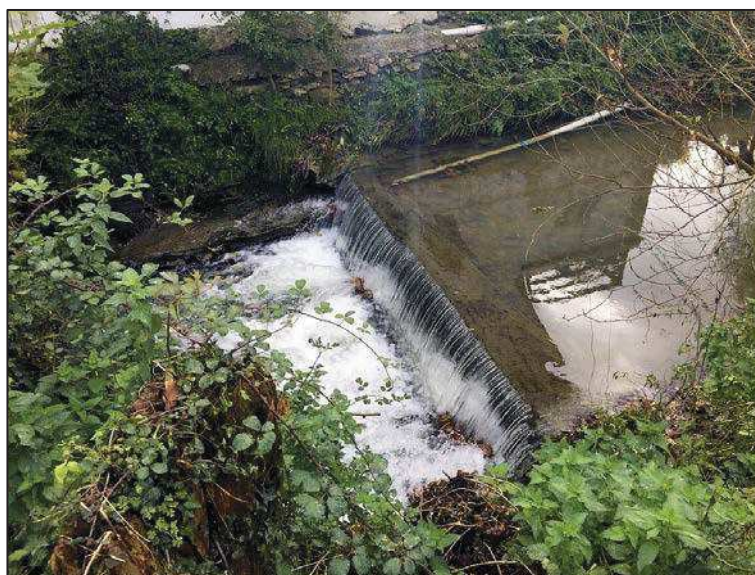
Foto nº7: Azud objeto del proyecto de demolición, de 0,8 m de altura
